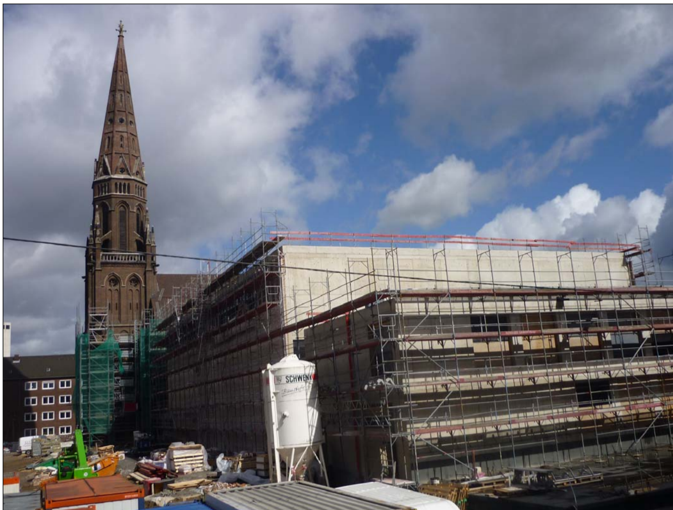
Die Baustelle des Musikzentrums im April 2015
